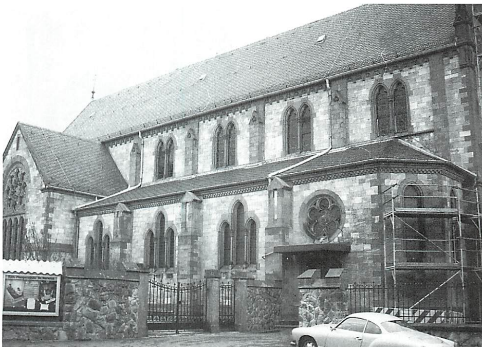
Blick von Westen auf die Taufkapelle ohne Dachhelm, Strebepfeiler und Gaubenabschlüsse.
