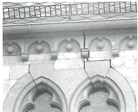
Resonanzriß am Schlußstein der Obergadenfenster an der Ostseite.
