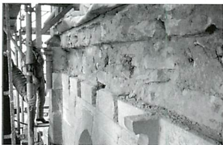
Renovierung des Dreißigstages.
